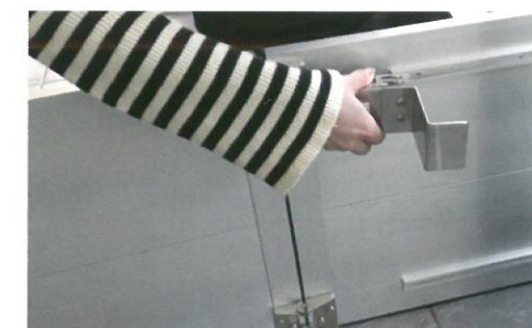
③レールに設置金具をセットして完了
